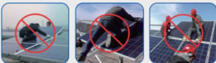
Stehen oder sitzen Sie beim Einbau oder bei der Reinigung nicht auf den Modulen und treten Sie auch nicht darauf.
